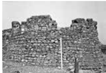
Figura 019 – Torre nordeste (NE) do Forte de Cachomba, Moçambique, 1972. Arquivo IICT.
