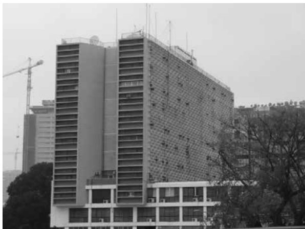
Ilustração 22 - Edifício Mutamba, largo da Mutamba, na cidade de Luanda. Projeto de Vasco Vieira da Costa, 1968. Fonte: Maria Alice Mendes Correia, 2012.
