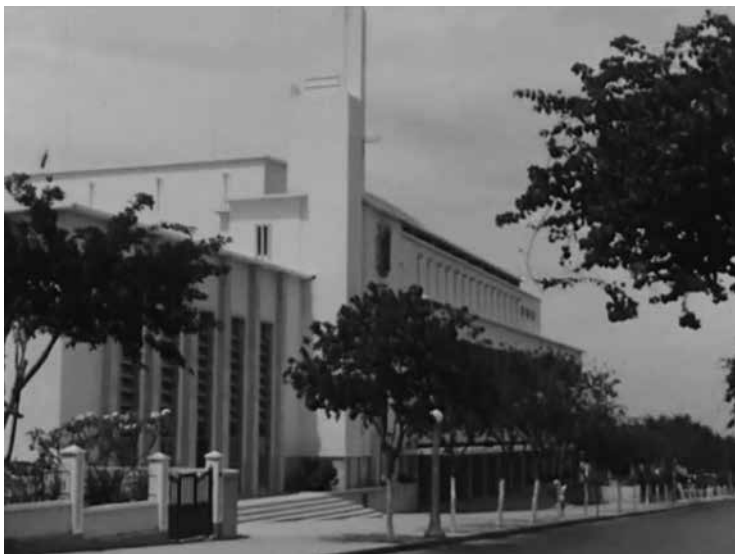
Ilustração 15 - Fachada principal do edifício do Cinema Restauração, rua de Álvaro Ferreira, na cidade de Luanda. Projeto da Castilhos Ltda., 1951. Fonte: Arquivo cedido por Gilberto Rita, 2018.
