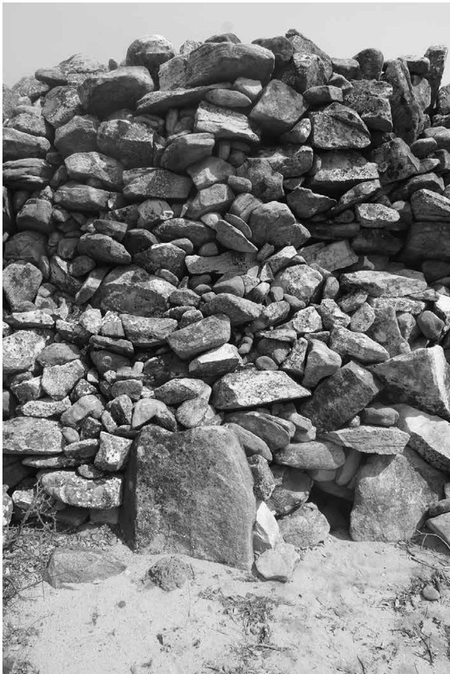
Ilustração 03 - Pormenor de um troço de muralha no Jau. Atente-se ao esteio que faz a contenção do aparelho. Foto de André Serdoura.
