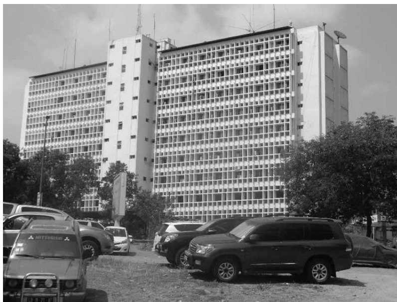
Ilustração 20 - Fundos do edifício da Junta Provincial de Povoamento 12 , largo dos Ministérios, na cidade de Luanda. Projeto de Rui Fernando Mendo. Fonte: Maria Alice Mendes Correia, 2017.
