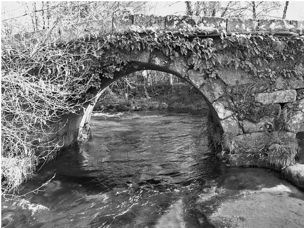
Fig. 19 – Tropoz - Arco redondo da Ponte da Igreja
