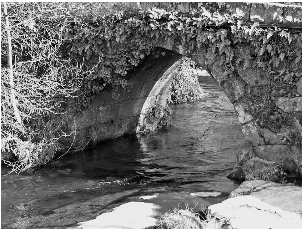
Fig. 20 – Troporiz – Arco pequeno da Ponte da Igreja
