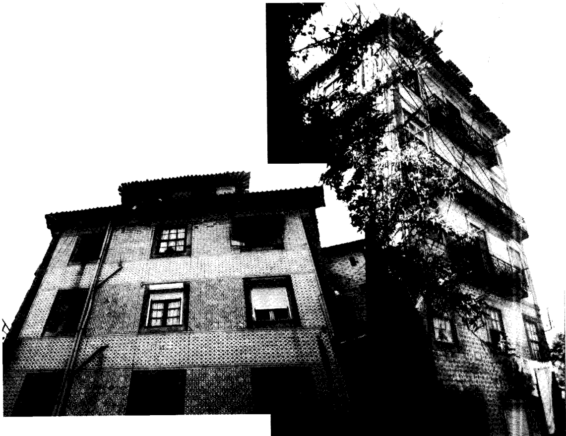
Fig. 13 – Localização e estado actual das instalações da Fábrica do Vale de Piedade.
