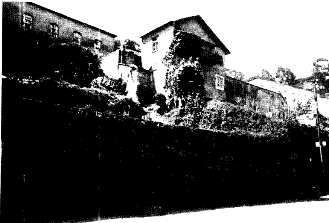
Fig. 11 - Estado actual das instalações das Fábricas do Cavaquinho.
