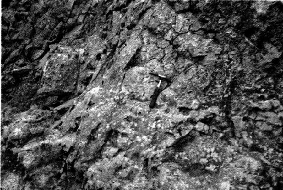
Fot. 13 - Perfil de Cimo de Vila. Pormenor da fracturação
