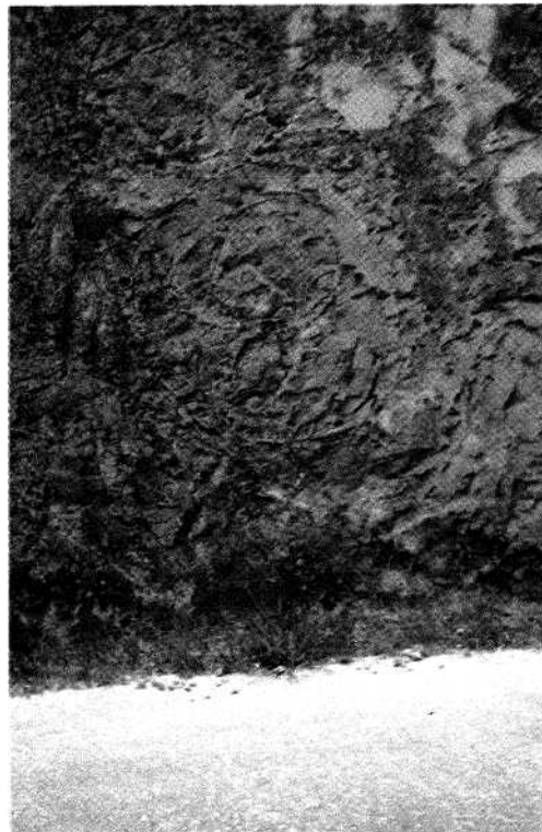
Fot. 14 - Perfil de Cimo de Vila. Imbricação de bolas graníticas, sem faixa de transição notória
