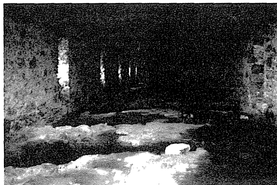
3 — Aspecto geral de ruína do interior do moinho de maré, que o programa de musealização pretende manter.
