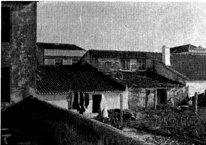
Fig. 6 — Na casa da direita notam-se as traseiras do falso, erguido acima do telhado da cozinha. Na da esquerda não existe falso. (R. Miguel Bombarda).
