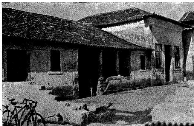
Fotog. 2 — Pardelhas — Casa do tipo 3.
