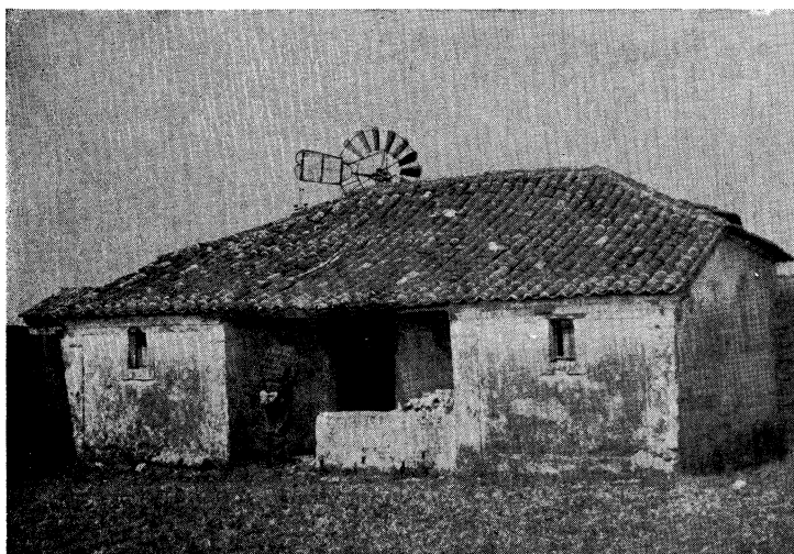
Fotog. 1 — Pardelhas — Casa do tipo 1.
