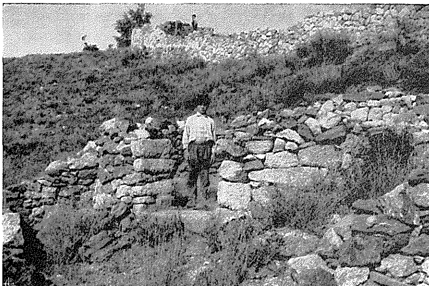
Fig. 3 — Casa com vestibulo antes da limpeza do mesmo.
