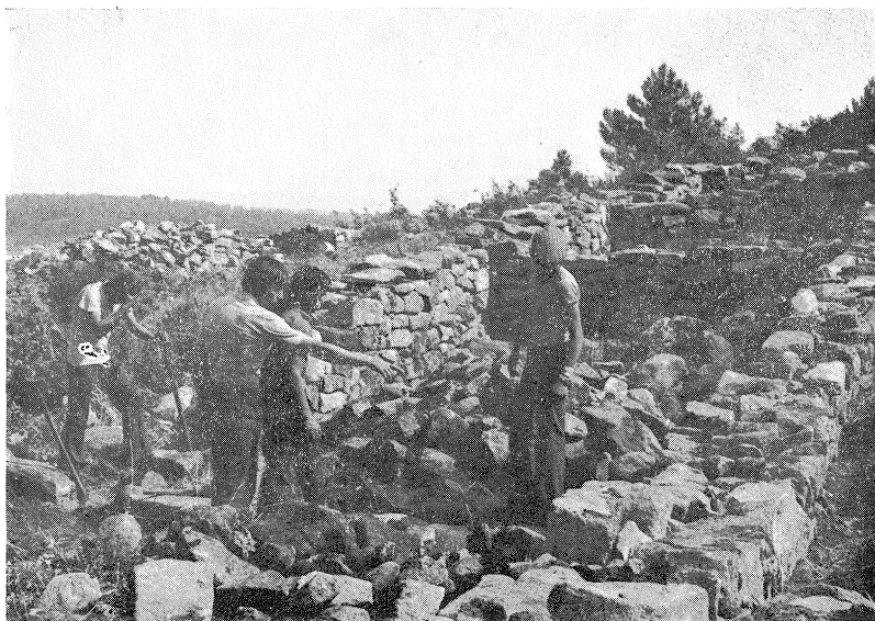
Fig. 6 — Aspecto dos trabalhos na casa n.º 11.
