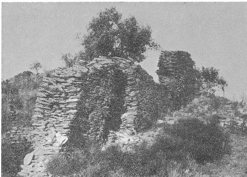
Fig. 5— O que resta duma parede com 1,10 m de grossura. Tem 20 m de comprimento com altura de 2,70 m convexidade da 1.<sup>a</sup> porção e 3 m de altura na parte terminal atorreada.
