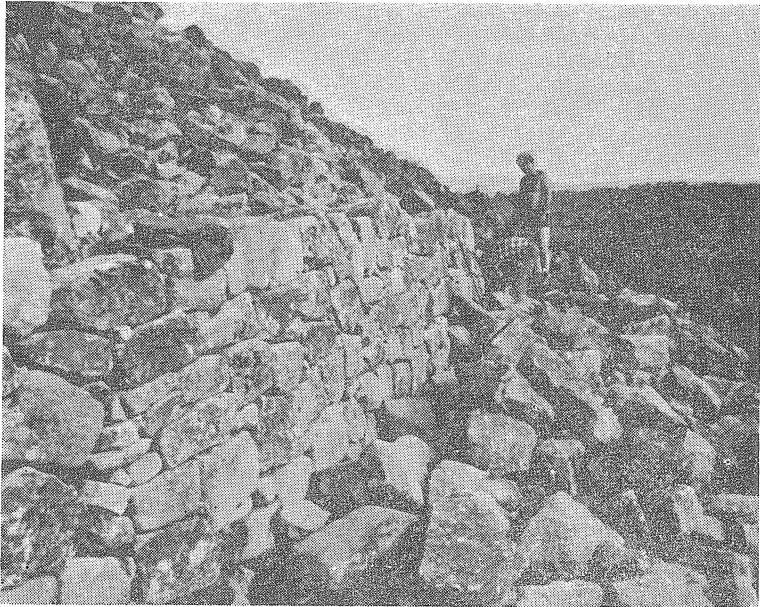
Fig. 8— Outro aspecto dos trabalhos de reconstrução da 2.ª muralha a Sul.
