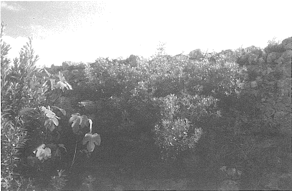
Fig. 17 — Fotografia da muralha de Conímbriga. Numa fase mais avançada observa-se a presença de arbustos e árvores como sejam o Ficus carica L. e a Pistacia lentiscus L. São ambas plantas de grande porte, com largas exigências minerais, causando um dano muito grave no substrato, quer químico pela exudação das raízes, quer mecânico, pelo crescimento das suas raízes.
