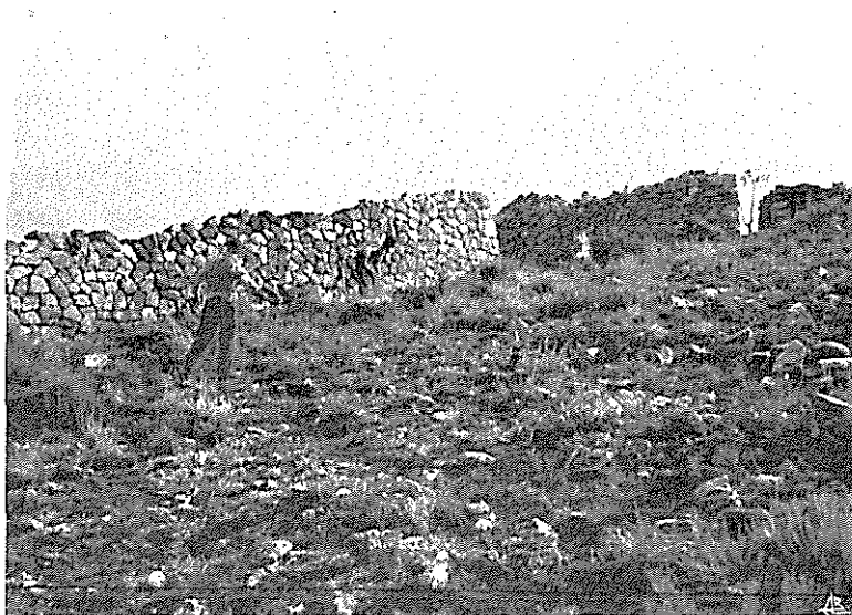
Fig. 22 — Aspecto da porção cimeira da muralha do alinhamento do noroeste. À direita vê-se a passagem da muralha exterior.
