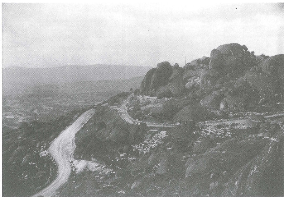
Fig. 4 – Vista do local onde se implantará a Capela da Nossa Senhora da Penha antes da sua construção.
